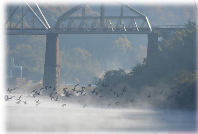
JR関西本線：木津川橋梁
