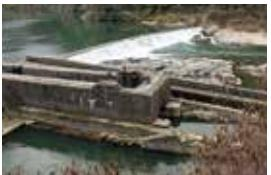
発電所前の運河。現在は使用されていないが、手前のトンネルをくぐると扉が閉まり、閘室の水位が上がり、上流へと進める仕組み。（マップ①）
