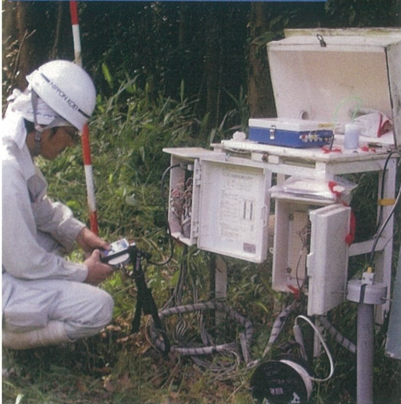
計器観測状況 パイプ歪計・地下水位計
