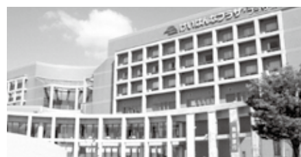
けいはんなプラザ交流棟
